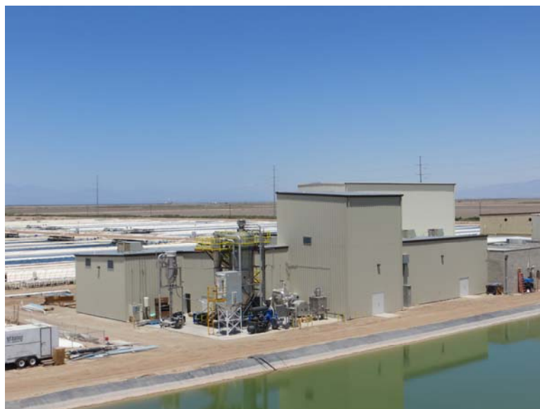
増設を行う天然系青色素抽出工場
